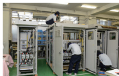
施設や機械の電力供給を制御する「配電盤」「制御盤」の設計から製作まで手掛ける
