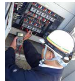
現場のプロたちが、技術の提案から修繕工事までトータルで対応する
