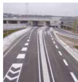
小・中学校の改修工事から大規模な道路や下水道の施工まで、多様な公共工事を手掛けている
