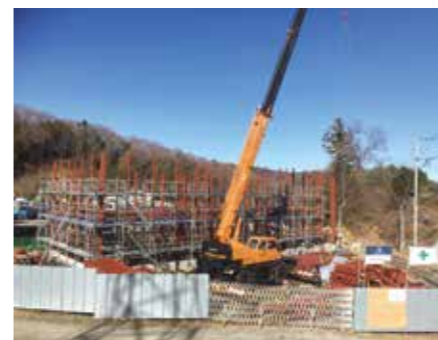
建築現場の様子。地元へ愛され、地域に貢献する建設会社として成長を続けている
