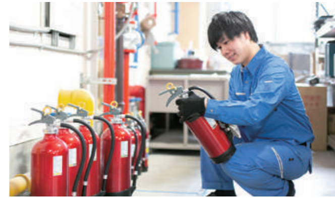
消火器を磨く工藤さん。点検には細かい確認事項があり、一つひとつ確実に作業を行うことが求められる
