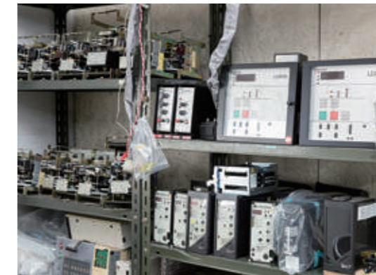
保護継電器、遮断器など、社員の練習用に各種の機器がストックされている
