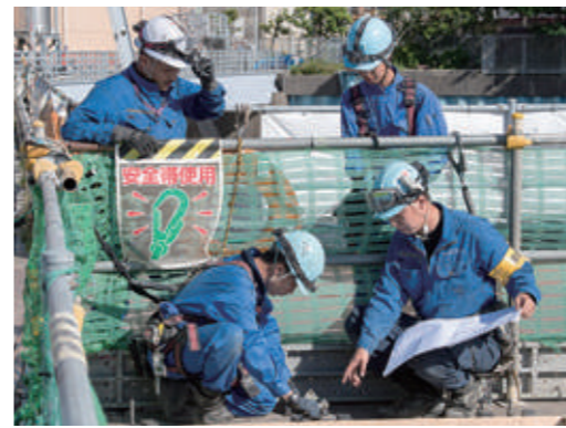
現場ではチームワークの良さが安全の確保や作業の効率化につながる
