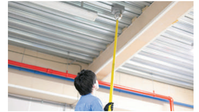
火災報知器の点検作業の様子。建物の規模に応じて適正に設置されているか、検知器の感度に問題はないかなどをチェックする
