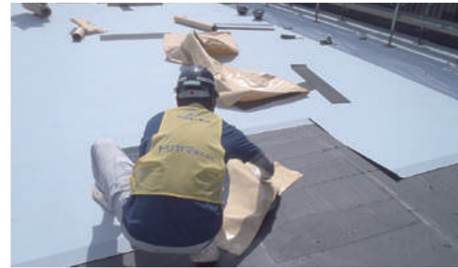
屋上の防水工事。不具合があれば雨漏りや鉄骨の腐食にも直結するため、丁寧な作業が求められる
