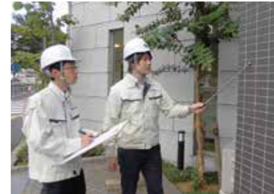
修繕工事では、同社の社員は顧客窓口として対応し、実際に施工する現場で建物状況を確認
