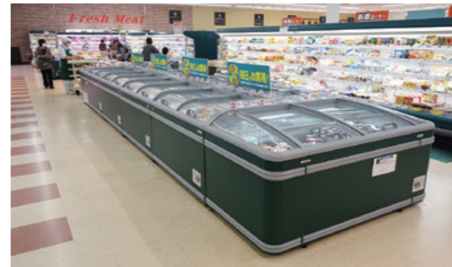
欧州を代表するメーカーから仕入れる冷凍ショーケース。プラグイン型なので配管工事不要で、使い勝手が良いと好評という
