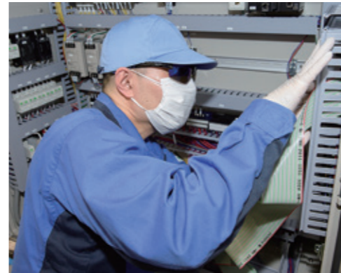
制御盤の配線を行うスタッフ。設計、加工、組立て、メンテナンスまで手掛けるため、幅広い技術が身に付けられる
