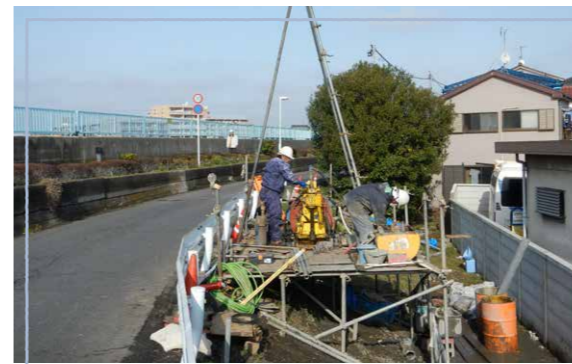
水害防止のための堤防建設計画の際に実施された地盤調査の様子。まずは足場を組んで調査のための機械をセットする
