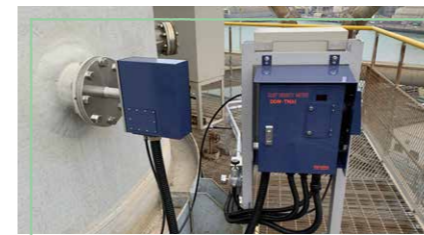
顧客の工場に設置されたダスト濃度計。社員を集い、全国の設置現場を訪問する機会もあるという
