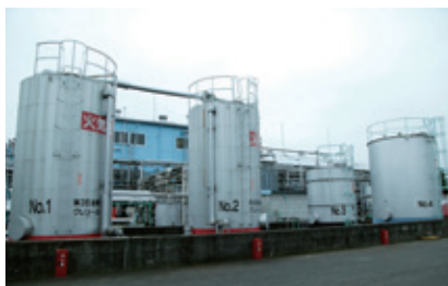
原材料の貯蔵タンク。複数の原材料を使用して絶縁塗料は製造されている
