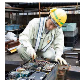
列車の行く先を変えるために線路を動かす転轍機。安全な鉄道運行のために入念に確認
