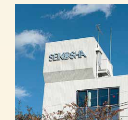
府中市に本社ビルを構え、落ち着いて業務に集中できる環境を実現している
