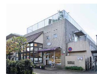
緑豊かな住宅街にあり、地域と共存する生活支援施設「大沢にじの里」
