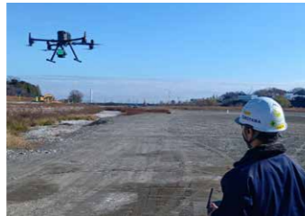
ドローンを使った測量の様子。取得データはICT建機の操作にも生かされる
