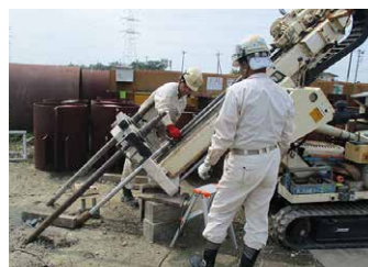
現場は共同作業。チームワークが安全と作業の効率化につながる
