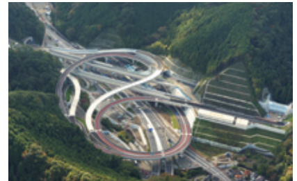
角田さんが測量を手がけた圏央道。写真は、高尾山インターチェンジ
