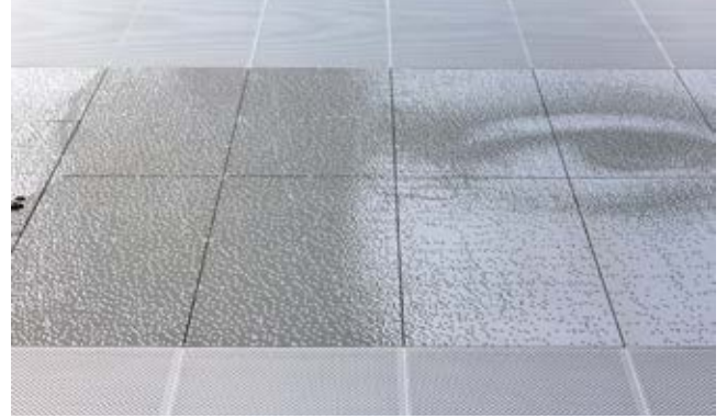
特許を取得しているパーフォアート。お客様のイメージ(デザイン画や写真)を、プレス打ち抜き加工で表現。
