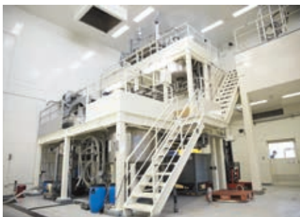
3階建て相当の高さがある大きな工場。写真の奥には数mの大型の調合釜がある
